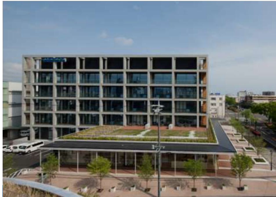
《 2 アウトフレームによる日射遮蔽 》
