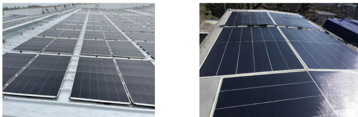
図 3.4-1 薄型軽量型パネルの設置例
