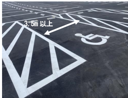
図 2.1-4 障害者向けの駐車場
