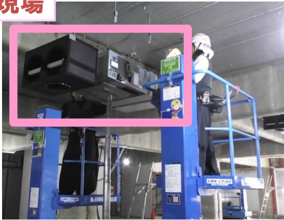
室内機とチャンバーを 一体設置
