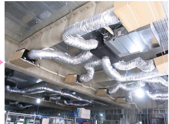
ダクト接続完了
