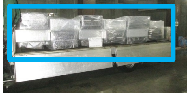
室内機とチャンバーを 一体化して搬出
