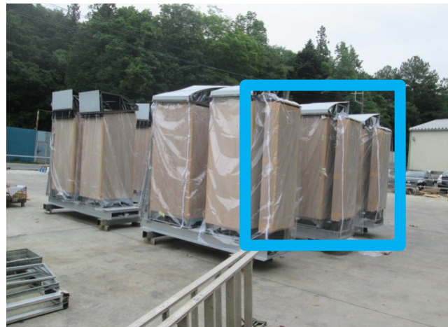
動力盤先行取付
