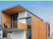
CLT工法による実験棟
