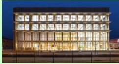
ハイブリッド集成材を主要構造部に用いた事務所
