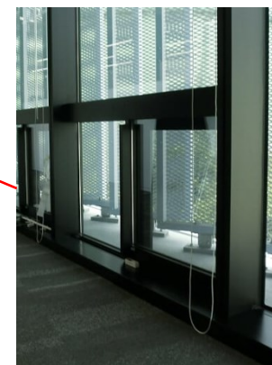
西側自然換気窓
