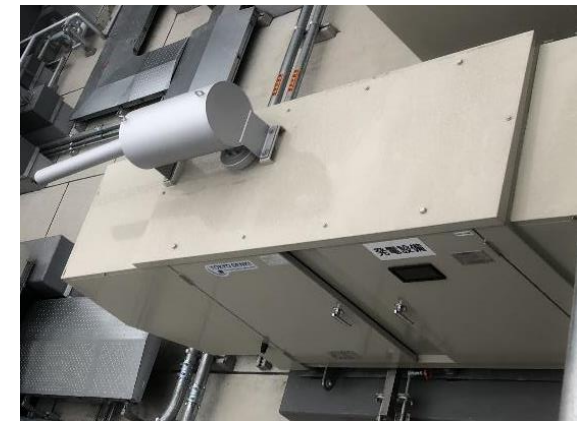
非常用発電機
