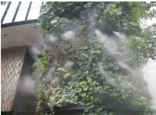
写真 4-28 壁面緑化とドライ型（微細）ミスト 19
