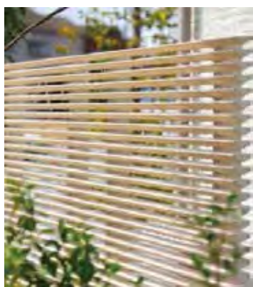
写真 4-24 冷却ルーバー 14
