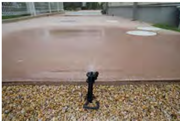
写真 4-23 保水性舗装と散水 13
