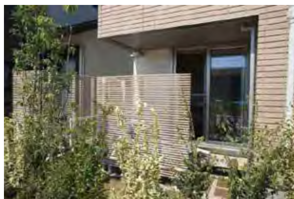
写真 4-25 冷却ルーバー 15
