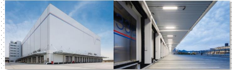
出典：「国内最大級の冷凍冷蔵倉庫で完全自動制御によるデマンドレスポンスを実装～無人化での調整力公募参加が可能に～」(東京電力ベンチャーズ株式会社・ニッスイ・エンジニアリング株式会社・株式会社前川製作所・株式会社松岡)
