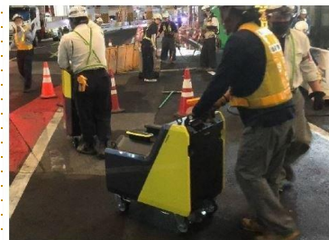
〈水素燃料電池発電機を運搬する様子〉
