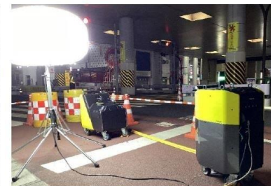
〈水素燃料電池発電機による照明利用の様子〉
