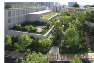
複数階にまたがる連続した屋上の緑は、建物の圧迫感を軽減し地上部緑地と調和しながら立体的な緑景観を形成。
