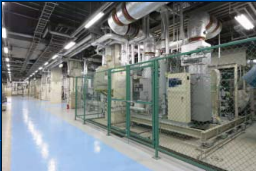
CGS ガスエンジンより機械室全景
