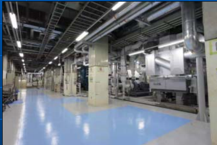
蒸気吸収冷凍機1200RTより機械室全景
