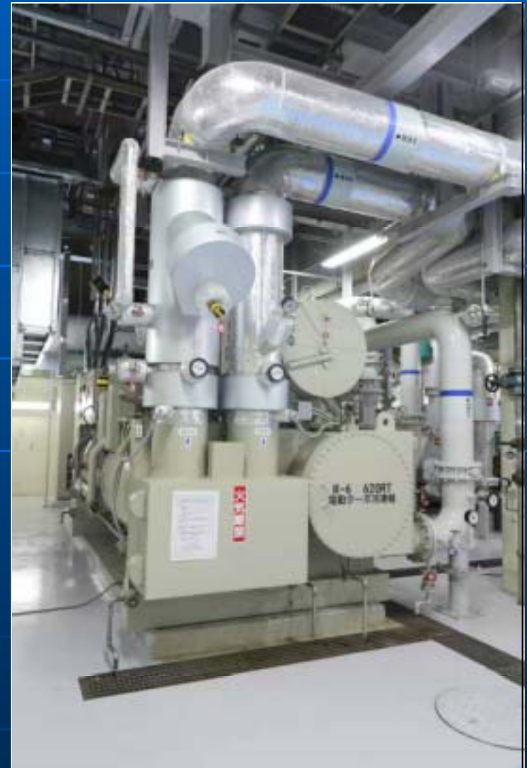
電動インバーターターボ冷凍機 620RT 1台
