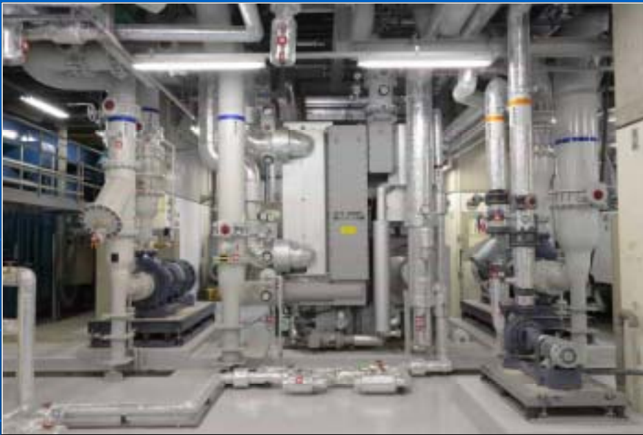
高効率排熱投入型蒸気焚き吸収式冷凍機 600RT 1台
