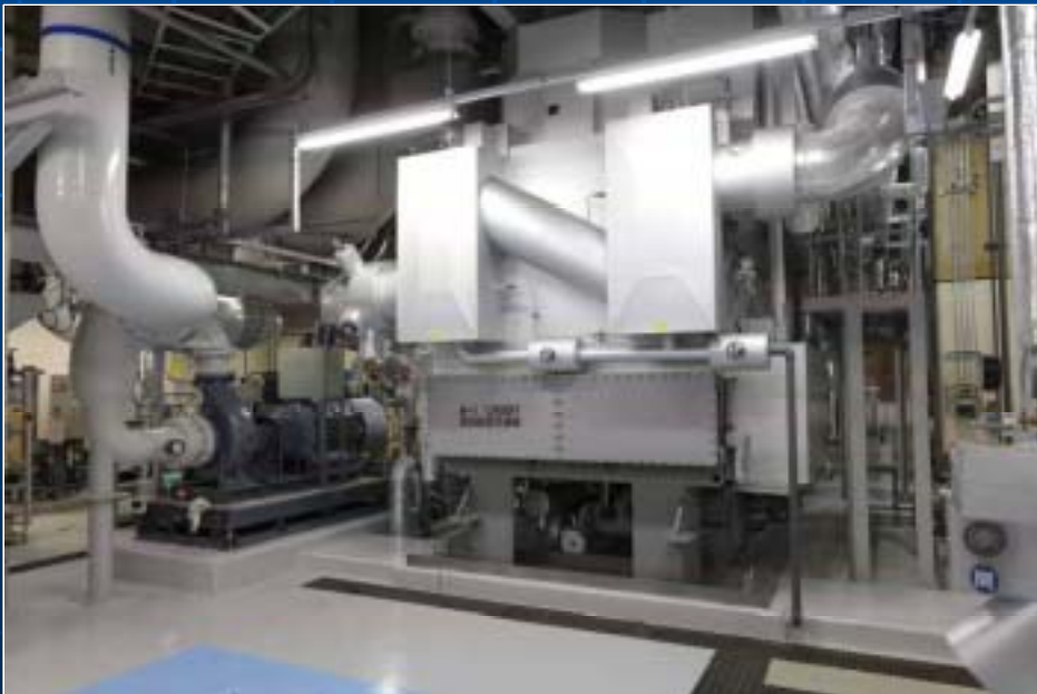
高効率蒸気吸収式冷凍機 1200RT 2台
