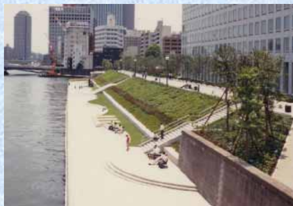
工事完了後の様子
